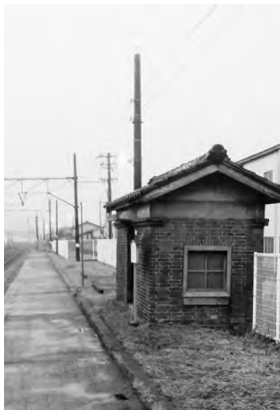
三条駅に今も残るランプ小屋（車内灯・信号灯などに使用する油を保管するための煉瓦製油庫。明治31年の三条駅開業当時からのもの）
